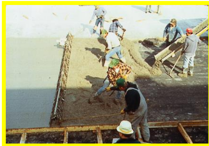
Fresh Slab Pour
